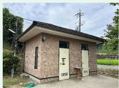
トイレ（男・女 水洗トイレ）
